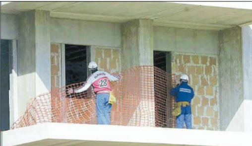
Un cantiere edile
